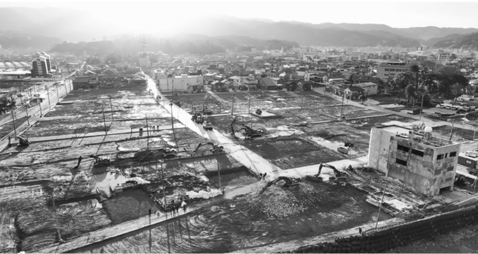
初日の出に照らされる石川県輪島市の「輪島朝市」周辺。大規模火災で焼失した建物の解体が進み、更地が広がる=1月1日午前8時2分（ドローンから）
